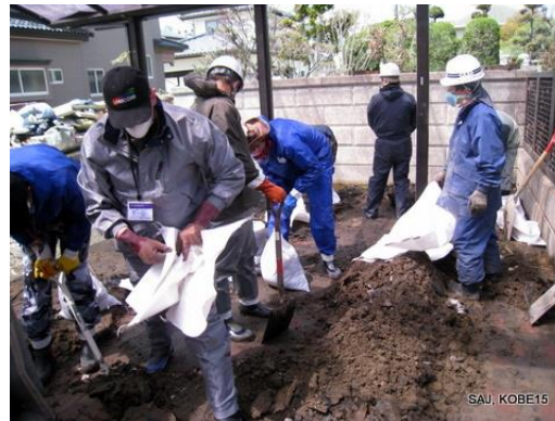
泥かき作業中
